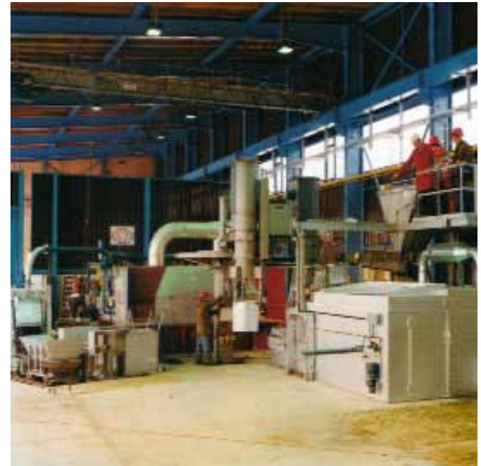
Fig. 1. Planta automatizada de galvanización a alta temperatura de tornillería.
