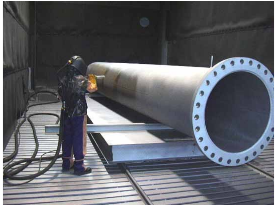
Figura 5: Tratamiento de limpieza por chorreo abrasivo
