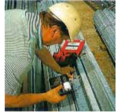
Figura 3: Medida no destructiva del espesor del recubrimiento galvanizado (inducción magnética).
