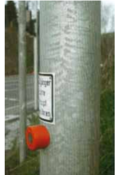
Fig. 2: Manchas blancas ligeras sobre el soporte de una luminaria. Estas manchas se transformarán en poco tiempo en capas protectoras del recubrimiento de zinc por la acción del anhídrido carbónico del aire. Solamente en el caso de querer pintar el soporte sería necesario limpiarlas.
