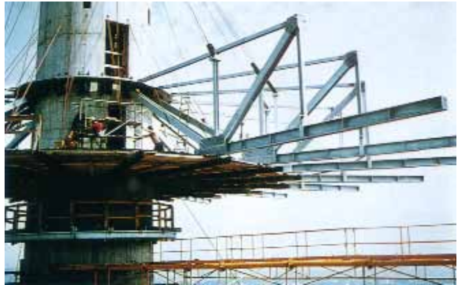
Fig. 3: Uniones con tornillos galvanizados de alta resistencia utilizados en la construcción de una torre de televisión
